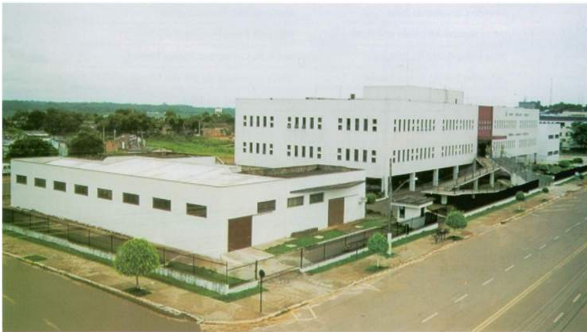
Atual sede do Tribunal, composta de dois pavimentos, de aproximadamente 2.000 m 2 cada, com Plenário (135 poltronas), e auditório (150 poltronas). Ao lado direito, o prédio do Almoxarifado e, ao esquerdo, o do Fórum Desembargador Lourival Mendes de Souza, onde funcionam as sete Zonas Eleitorais de Porto Velho.
