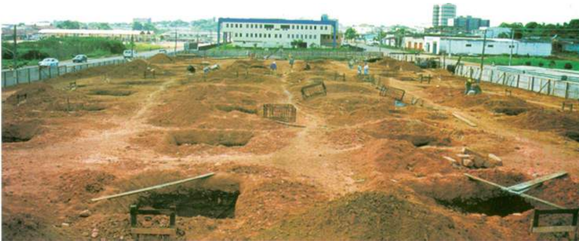
No final de 1997 iniciou-se a construção da sede própria do TRE. A foto acima retrata a vista, a partir da frente da Coordenadoria de Material; ao fundo o Fórum Ministro Jarbas Nobre, sede da Justiça Federal em Rondônia.
