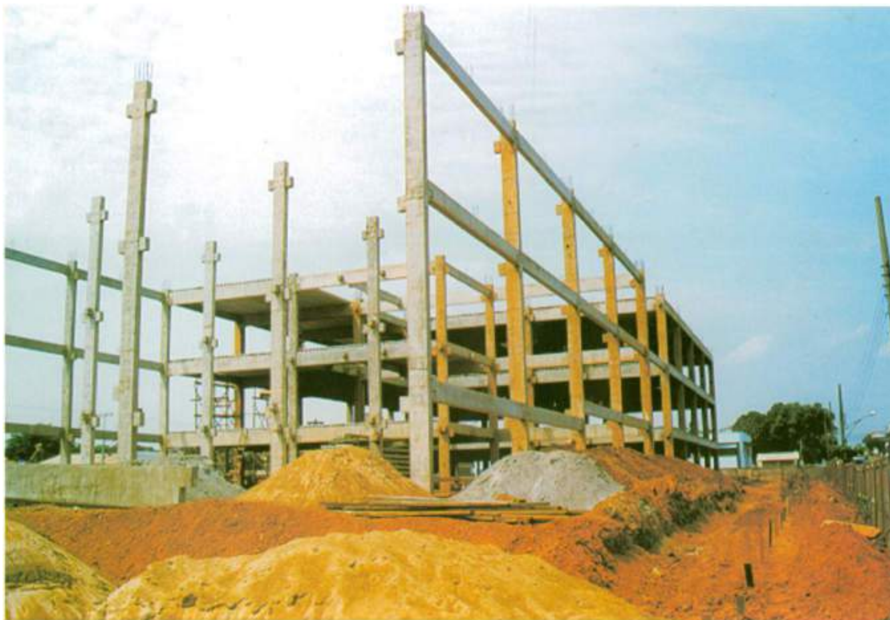
Em 199 , a estrutura base do prédio da futura sede do Tribunal Regional Eleitoral de Rondônia.
