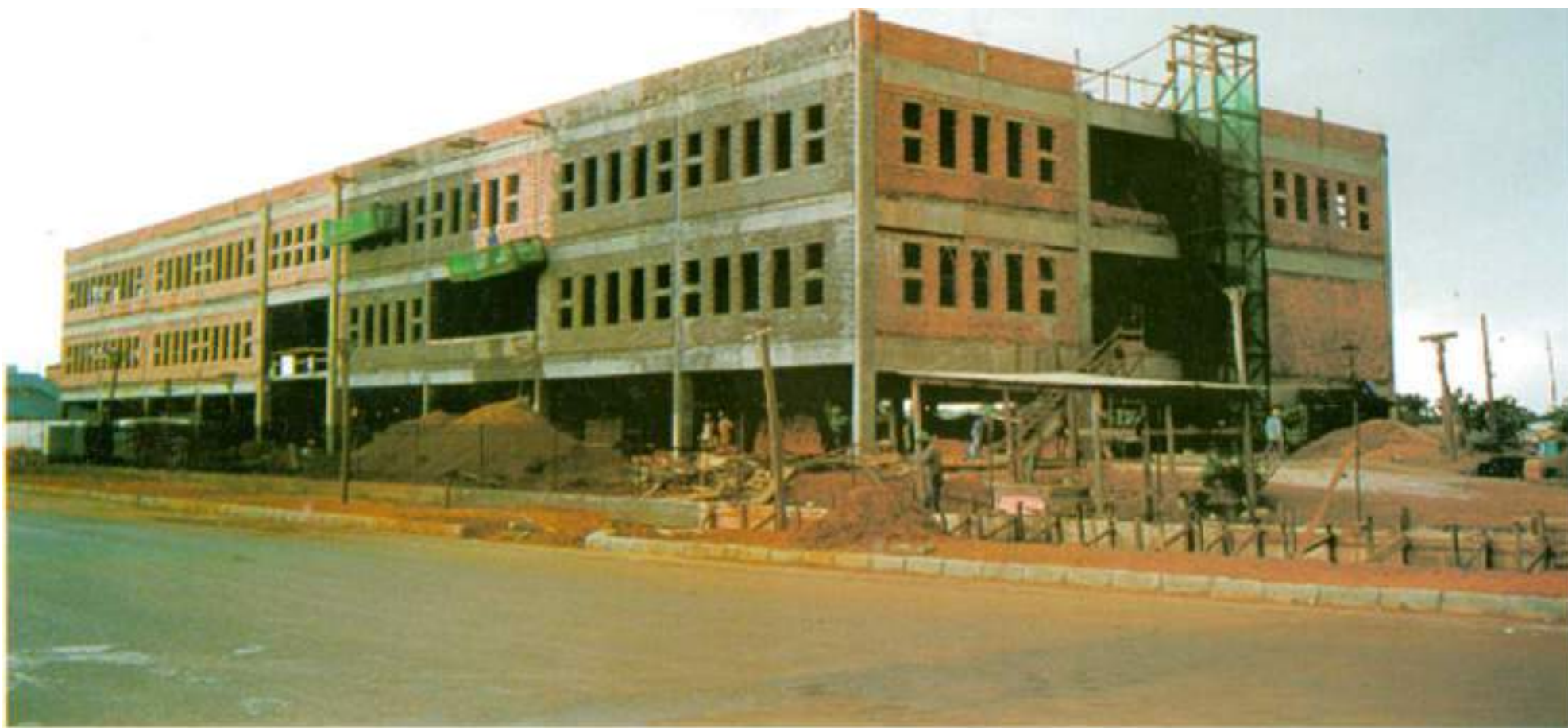
Fase final da construção da sede do Tribunal (1998)
