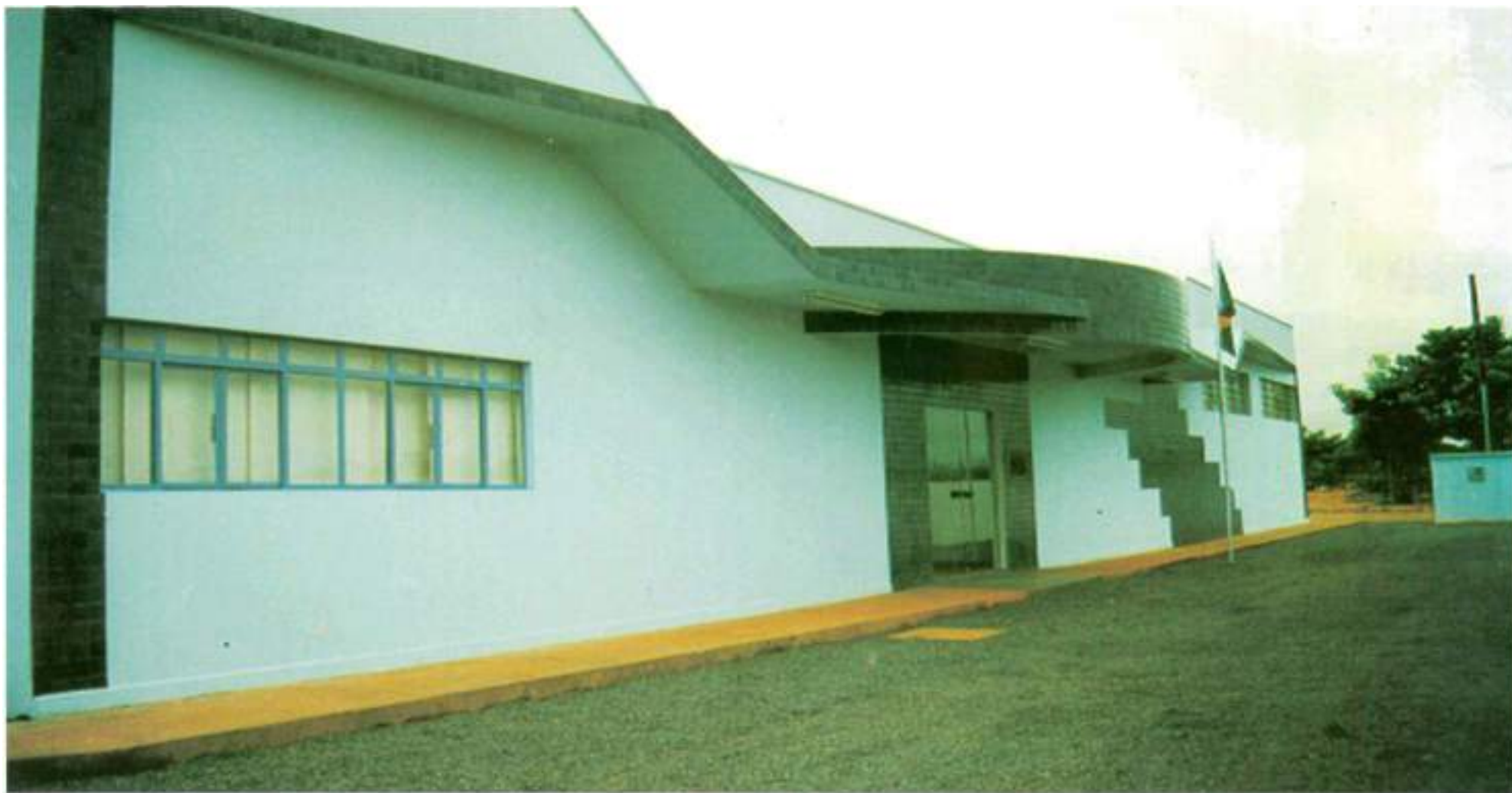
Primeira fase da utilização do terreno doado para construção da sede. Em 1997 iniciou-se a construção do prédio onde funcionou a Coordenadoria de Material do Tribunal, no qual, hoje, está instalado o depósito de urnas eletrônicas e a Seção de Almoxarifado.
