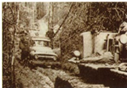
Construção da BR-364.
