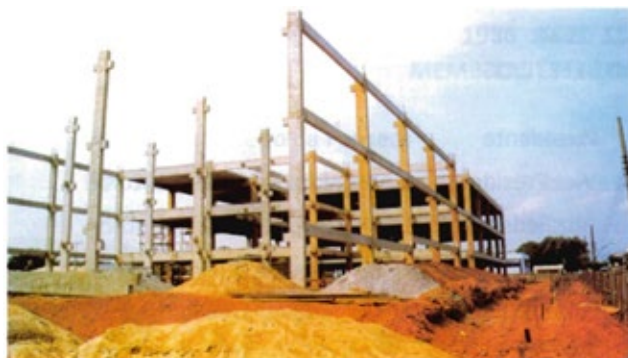
Em 1998, a estrutura base do prédio da futura sede do Tribunal Regional Eleitoral de Rondônia.
